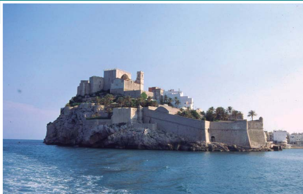
CASTILLO DE PEÑÍSCOLA (BAIX MAESTRAT, CASTELLÓN), VISTA GENERAL.
